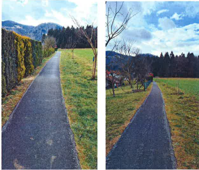
Sliki 2.6, 2.7 Pešpot - odsek Tabor brez urbane opreme in razsvetljave
