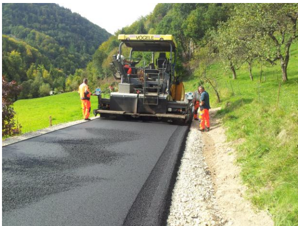
asfaltiranje odseka »Pri Tonu – Konjščica«
