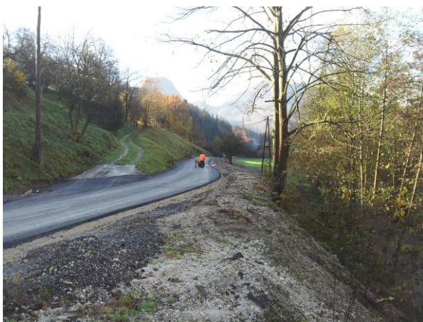
asfaltiranje odsekov »Loke – Ojstrica«
