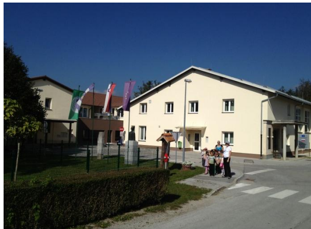
Po energetske sanacije
