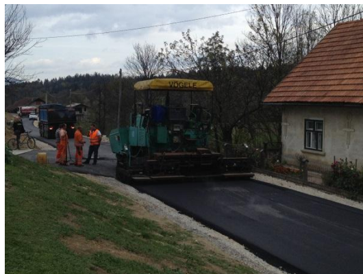
Asfaltiranje končnega sloja asfalta
