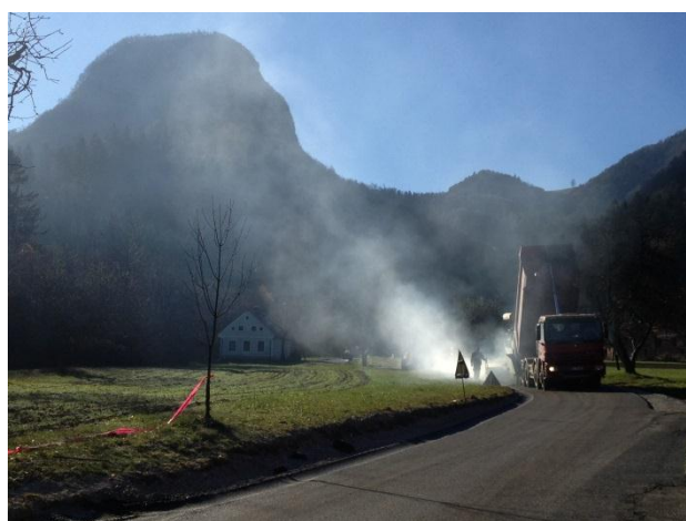
Asfaltiranje končnega sloja, 29. 11. 2013
