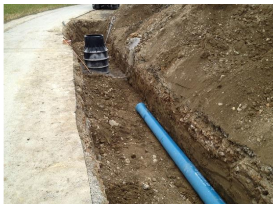
Polaganje kanalizacije in vodovodnih cevi
