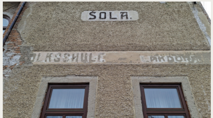
Volkschule Lakdorf – ohranjeni napis na pročelju šole v Lokah
